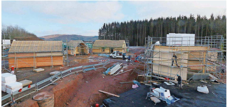
Innen entstehen fünf, außen drei Saunen. Alles in Anlehnung an die Kelten. So wird hier auch ein Feuerplatz in der Mitte gebaut.
