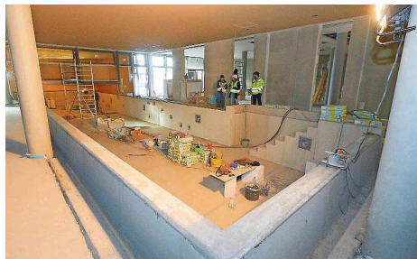
Das Schwimmbad nimmt so langsam Gestalt an, bald wird gefliest.
